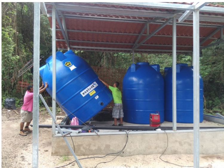
Figura 2 Construcción módulo Scall en el Campus UNA de Nicoya, llamado Nimbu I
